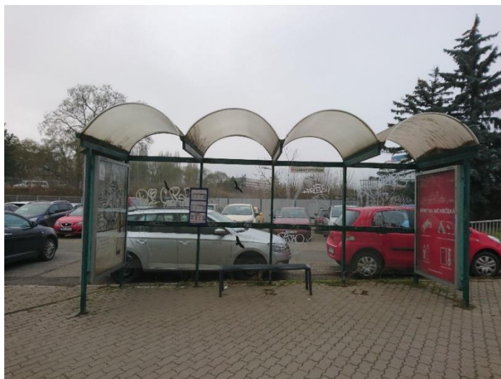
Obrázek 9 Přístřešek MHD zastávka Zimní stadion – čelní pohled [Zdroj: Vlastní]
