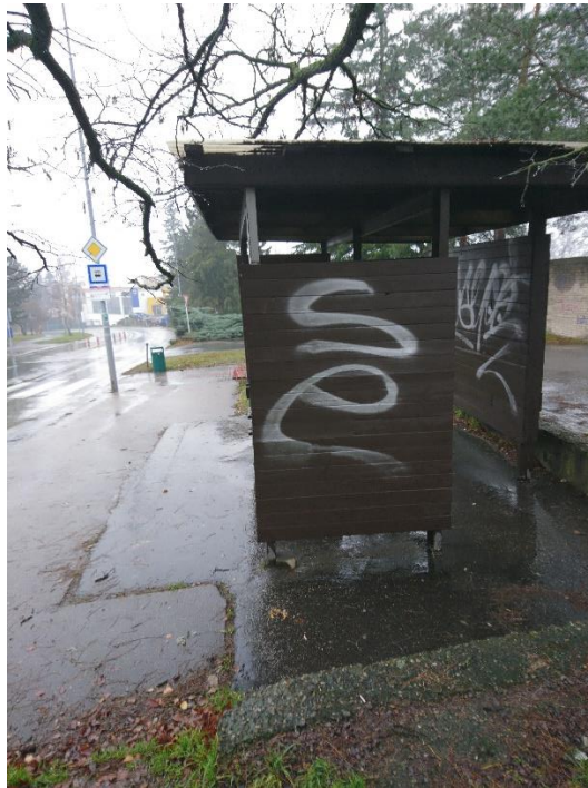
Obrázek 40 Přístřešek MHD zastávka Fillova – boční pohled [Zdroj: Vlastní]
