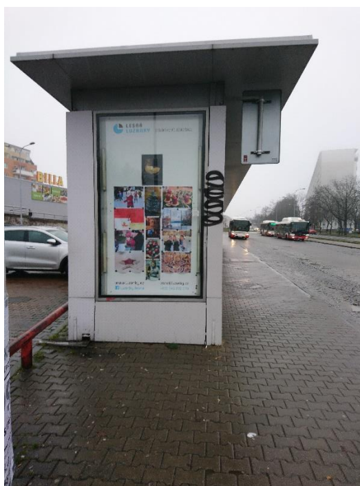
Obrázek 34 Přístřešek MHD zastávka Haškova – boční pohled [Zdroj: Vlastní]
