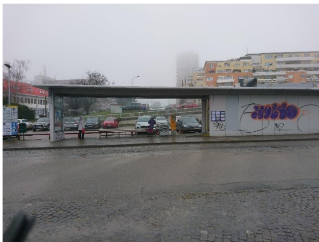
Obrázek 33 Přístřešek MHD zastávka Haškova – čelní pohled [Zdroj: Vlastní]
