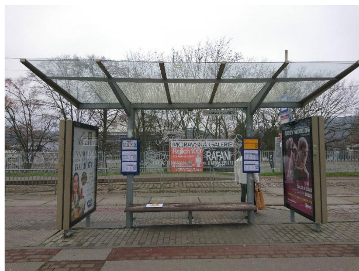
Obrázek 24 Přístřešek MHD zastávka Lipová (BUS) – čelní pohled [Zdroj: Vlastní]
