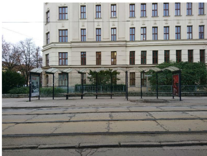
Obrázek 15 Přístřešek MHD zastávka Zemědělská – čelní pohled [Zdroj: Vlastní]
