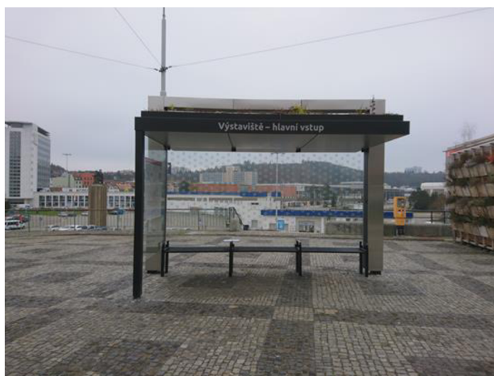
Obrázek 30 Přístřešek MHD zastávka BVV - hlavní vstup – čelní pohled [Zdroj: Vlastní]
