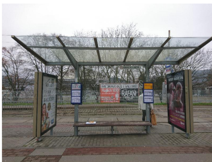
Obrázek 24 Přístřešek MHD zastávka Lipová (BUS) – čelní pohled [Zdroj: Vlastní]
