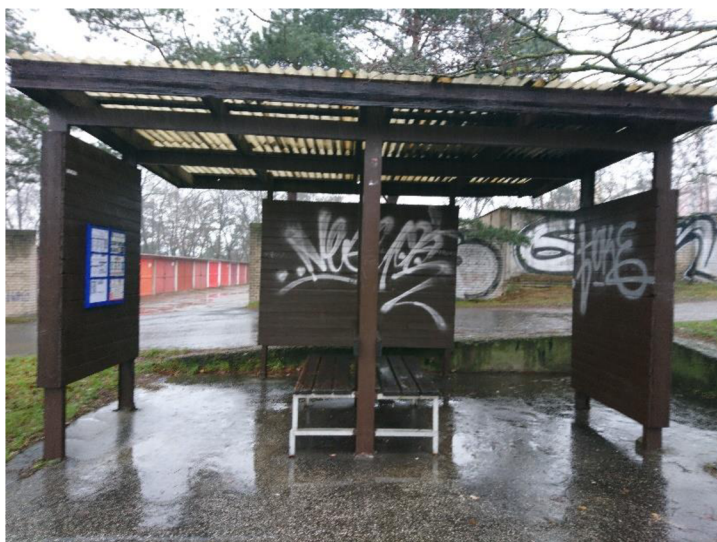
Obrázek 39 Přístřešek MHD zastávka Fillova – čelní pohled [Zdroj: Vlastní]
