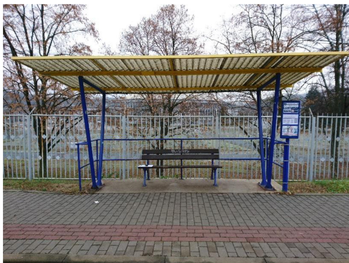
Obrázek 27 Přístřešek MHD zastávka Lipová (TRAM) – čelní pohled [Zdroj: Vlastní]
