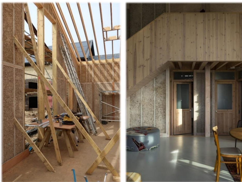
Obr. 1 Ukázka použití konopného zdiva a izolačních konopných panelů v interiéru v kombinaci s masivními konstrukčním sloupy, dřevěným schodištěm a dřevěným nábytkem – proces výstavby a užívání (Practice Architecture, 2020)
