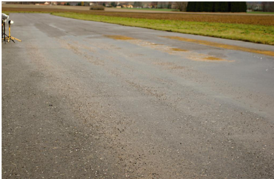
Obr. 38) Pole s různými počty průjezdů
