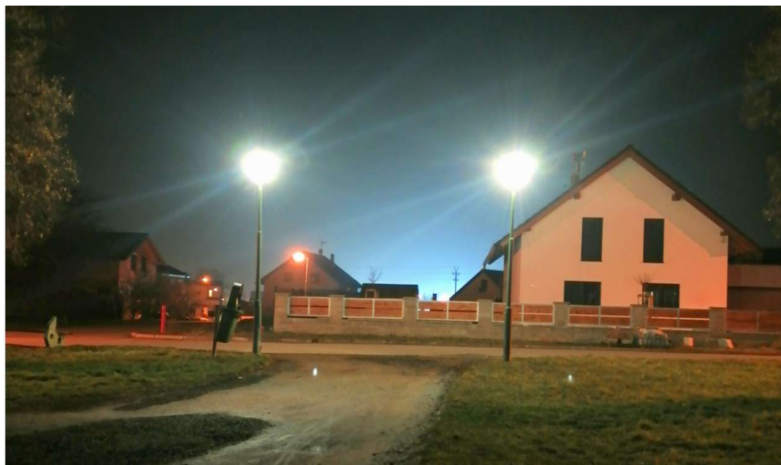
Obr. 16. Nevyhovující osvětlení cesty (zdroj: autor, 2021)
