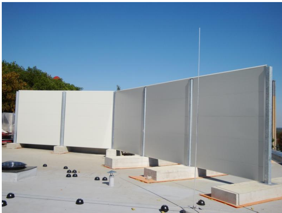
Obr. 4.10.1 Protihluková stěna mobilní s otvory, které umožňují částečné vnesení hluku
