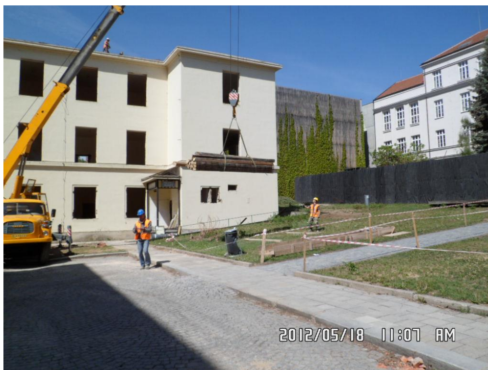
Obr. 4.10.4 Realizace protihlukové stěny (Centrum podpory humanitních věd CARLA, Filozofická fakulta MU) [63]
