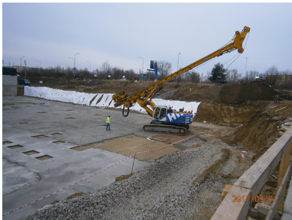
Obr. 7.23 Místní šetření a vyhodnocení tvaru terénu snížené základové spáry
