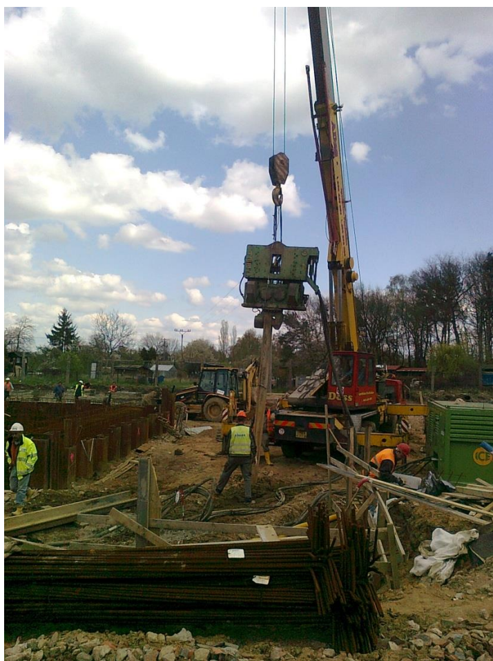
Obr. 4.5.1 Hlučné beranění podzemních pažících stěn LARSEN [62]
