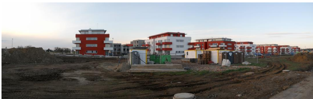
Obr. 4.5.5 Typ výstavby postupné, kdy je nutno chránit nastěhované obyvatelé před hlukem z výstavby, některé objekty jsou již v užívání, jiné ve výstavbě (Nové Pitkovice) [62]
