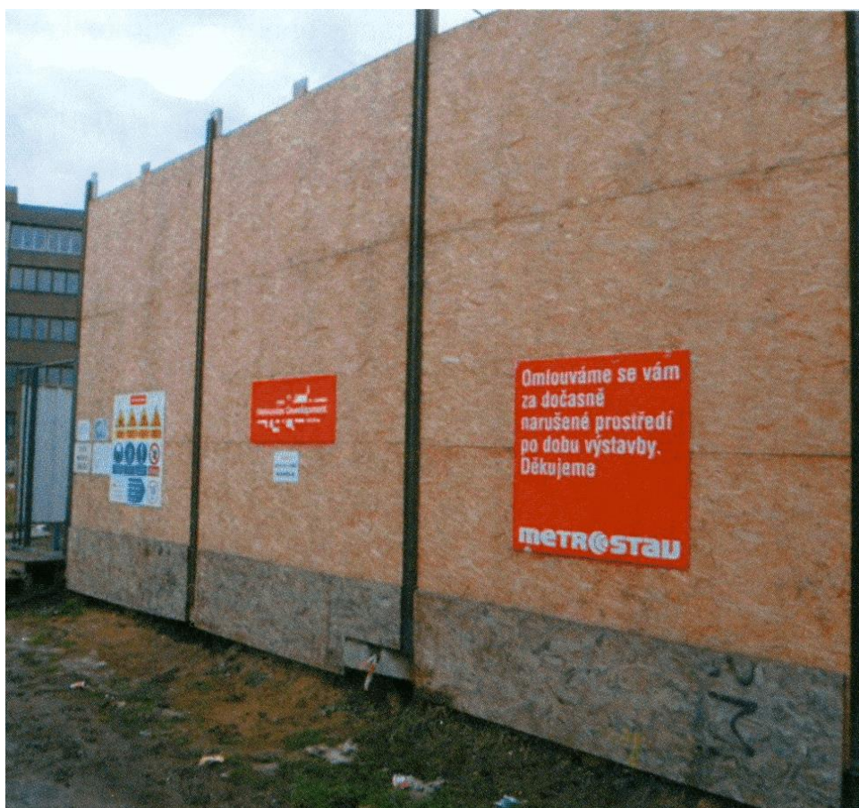
Obr. 4.10.2 Protihluková stěna mobilní kompaktní, bez možnosti částečného vnesení hluku
