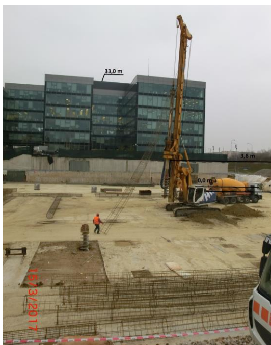
Obr. 7.14 Pilotovací souprava s označením úrovně zdroje a místa měření
