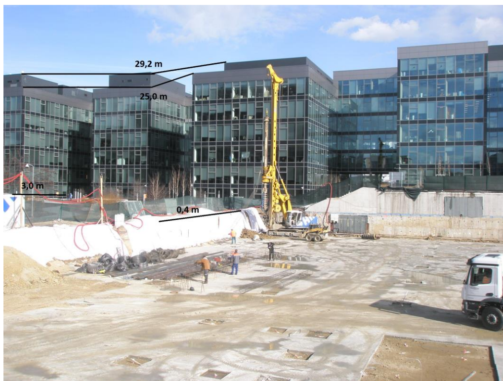
Obr. 7.21 Místní šetření a vyhodnocení tvaru terénu
