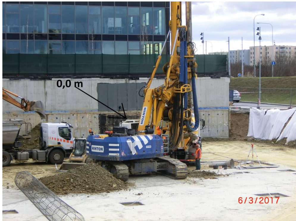
Obr. 7.12 Situace těžení - pilotážní souprava s umístěným hlukoměrem
