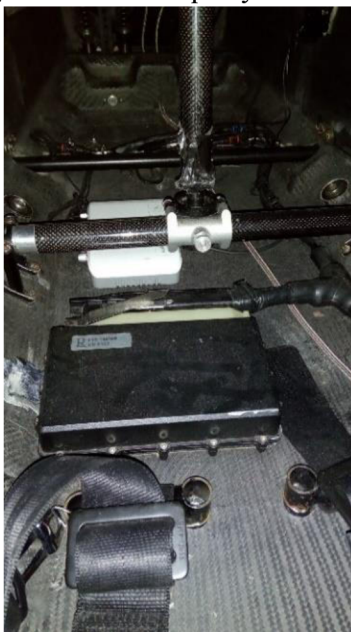
Obr. 37 Řídicí jednotka + router [Vlastní zdroj]
