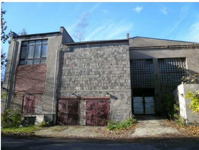
Obrázek 4: Kotelna Frýdlant – objekt brownfields
