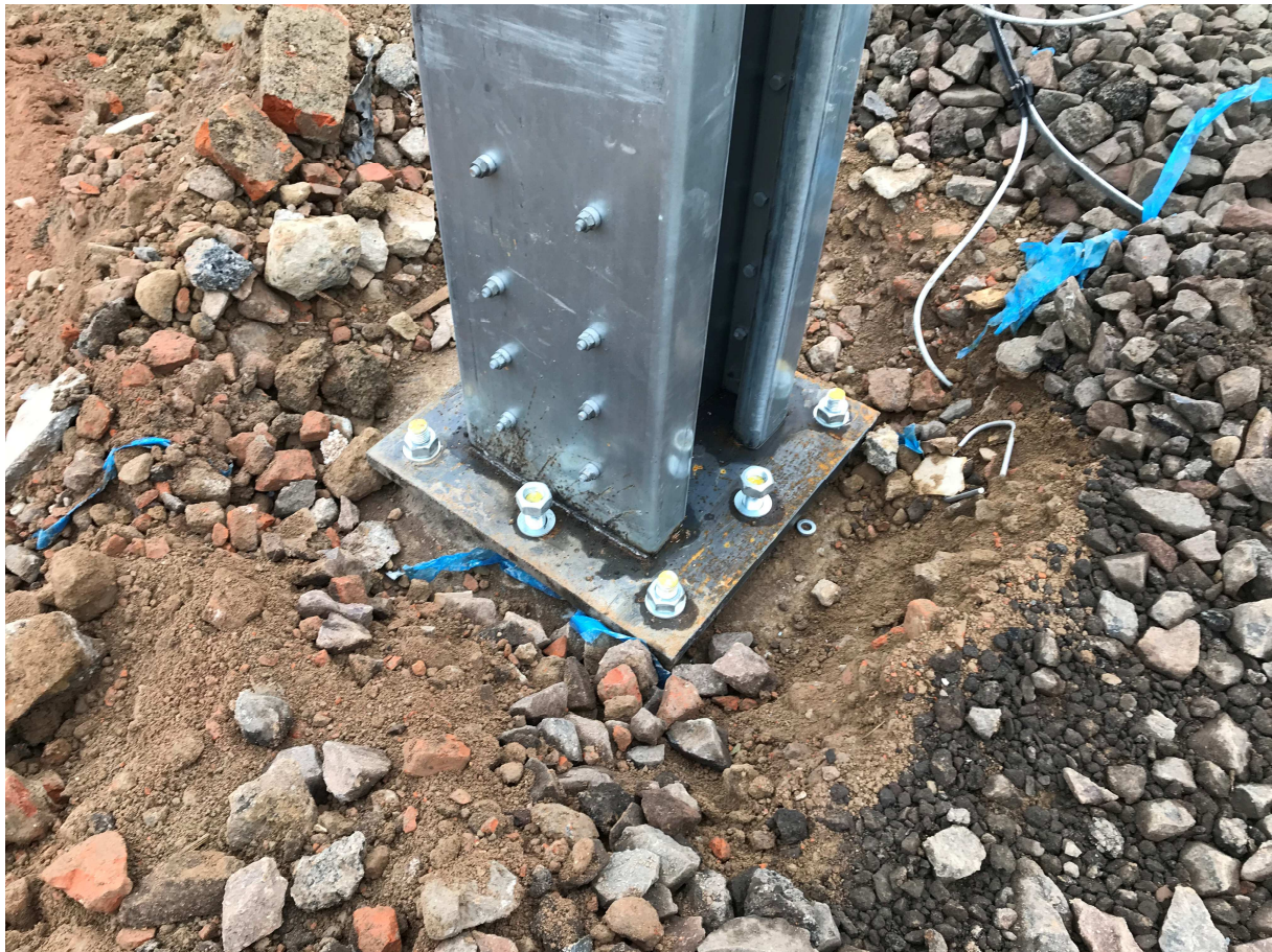
Obr. D. 5 Ilustrativní příklad kotvení sloupu systému Llentab
