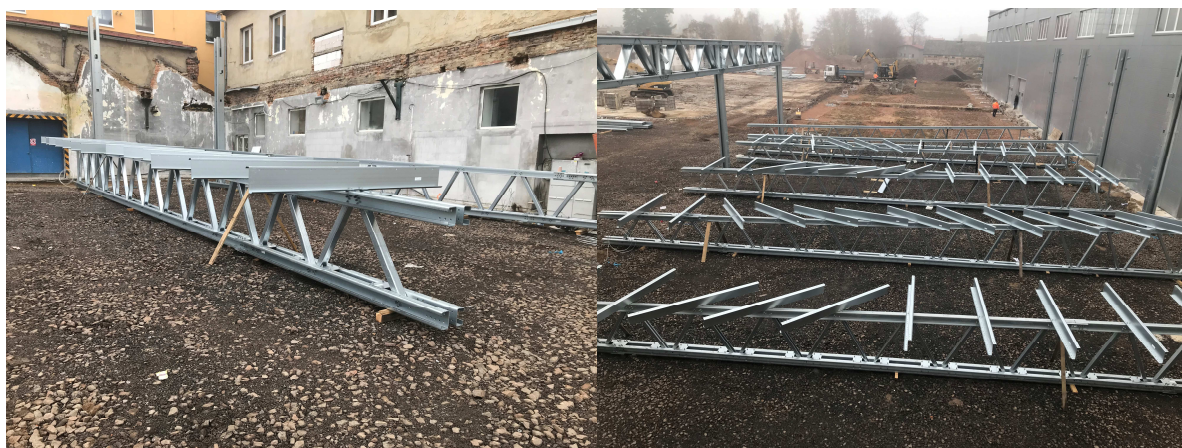
Obr. D. 6 Ilustrativní příklad předmontáže vazníků a části vaznic ze systému Llentab
