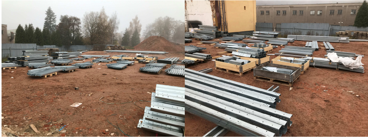
Obr. D. 2 Ilustrativní příklad skladování systému Llentab
