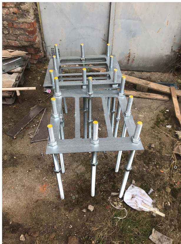
Obr. D. 3 Ilustrativní příklad kotevního bloku systému Llentab
