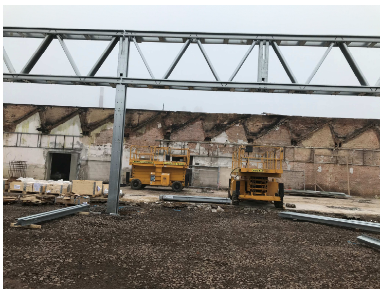
Obr. D. 7 Ilustrativní příklad montáže vazníku nebo průvlaku ze systému Llentab
