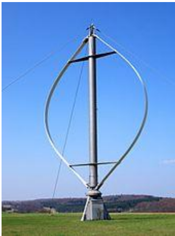
Obr. 18 Větrná elektrárna postavená r. 1987 v Kanadě, výška 110 m. [50]
