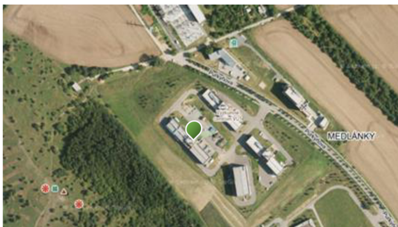
Obr. 27 Letecký pohled na areál AdMaS s vyznačeným bodem měření na střeše budovy
