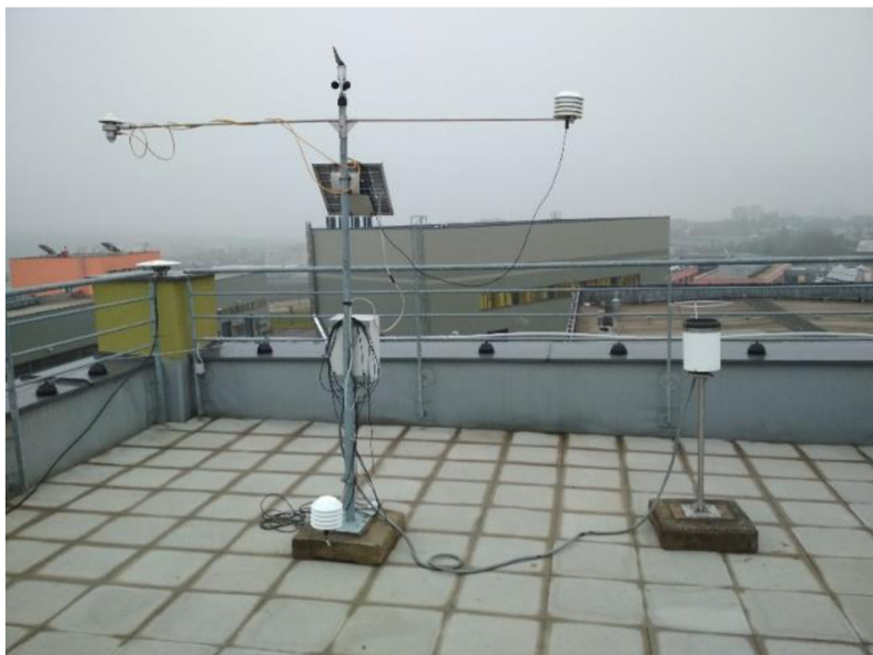
Obr. 29 Meteorologická stanice umístěná na střechu budovy P4
