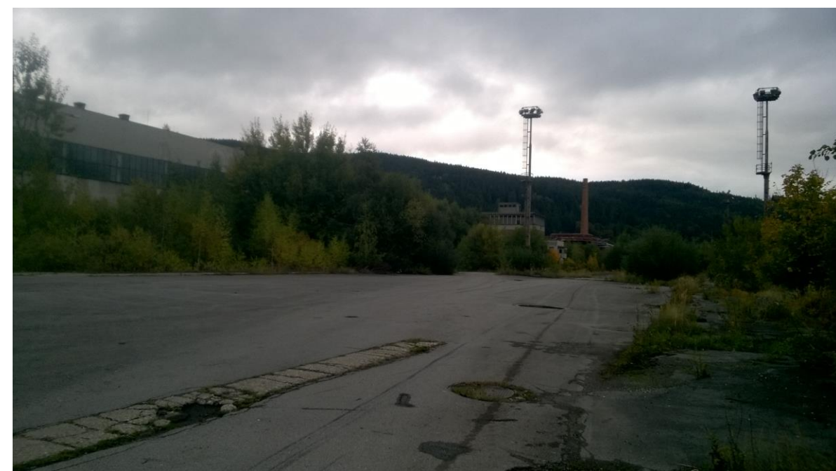
Obr. č. 30 Fotografie aktuálního stavu – pohled na plochu bývalých dřevotřísek
