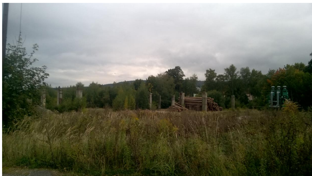
Obr. č. 29 Fotografie aktuálního stavu – sloupy zarůstající nálety
