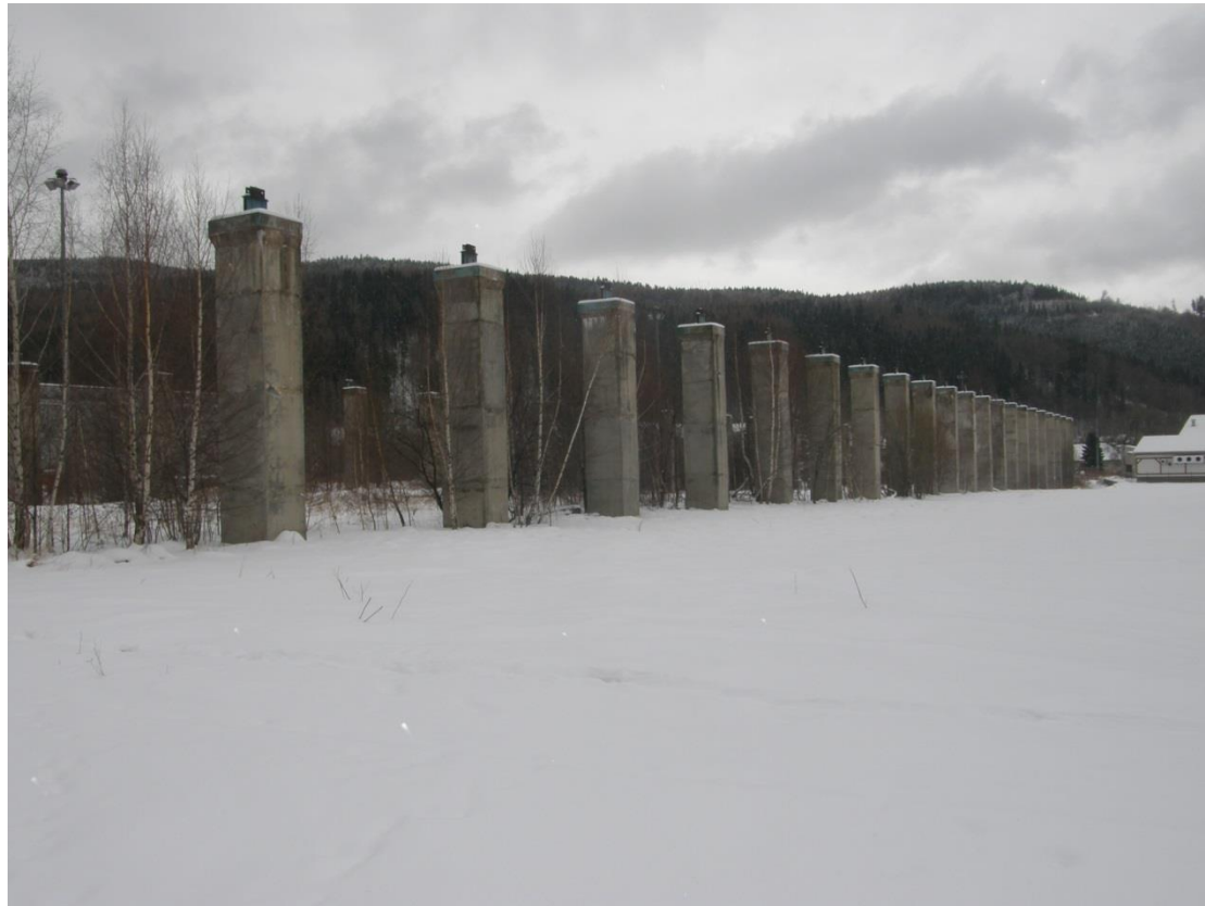
Obr. č. 24 Aktuální fotografie – sloupy původní jeřábové dráhy
