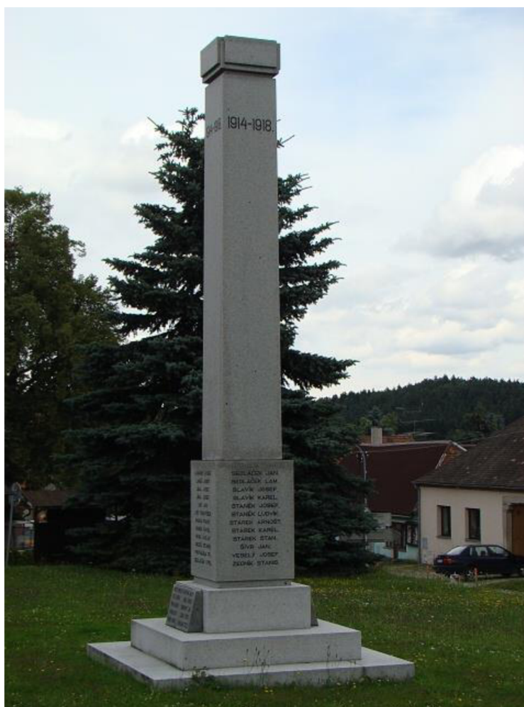
Obr. č. 3: Odlomený kus prvního monolitu, postavený na Mrákotínském náměstí (krasnecesko.cz)
