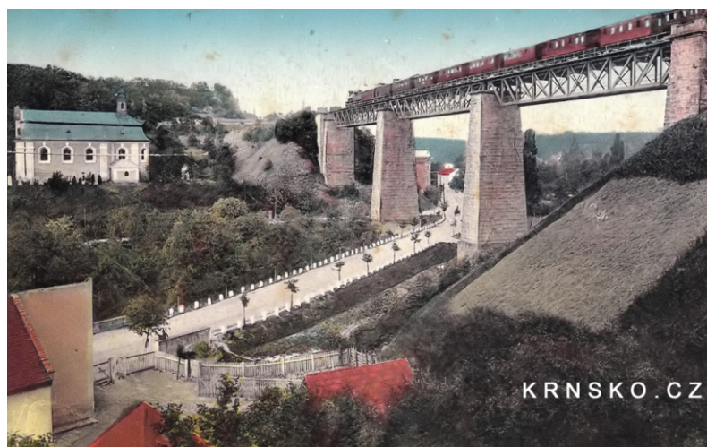
Obrázek 7 železniční viadukt z roku 1884
