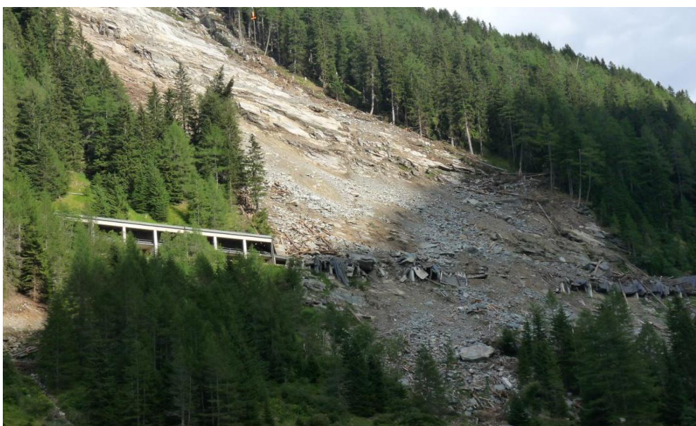
Obr.8: Skalný zosuv na cestu pri Zell am See (A) – 14. 5. 2013 príčina zosuvu - dlhá zima, topiaci sa sneh, dažde. [17]
