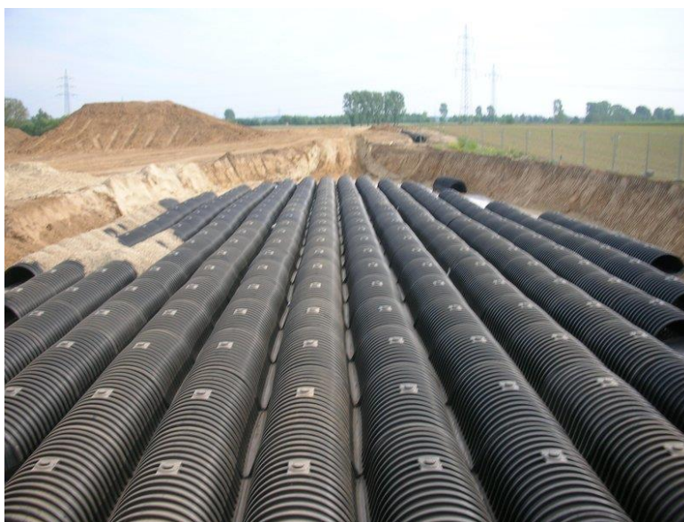
Obrázek 12: Ukázka instalace tunelového systému AS-KRECHT ( https://www.asio.cz/cz/as-krecht )
