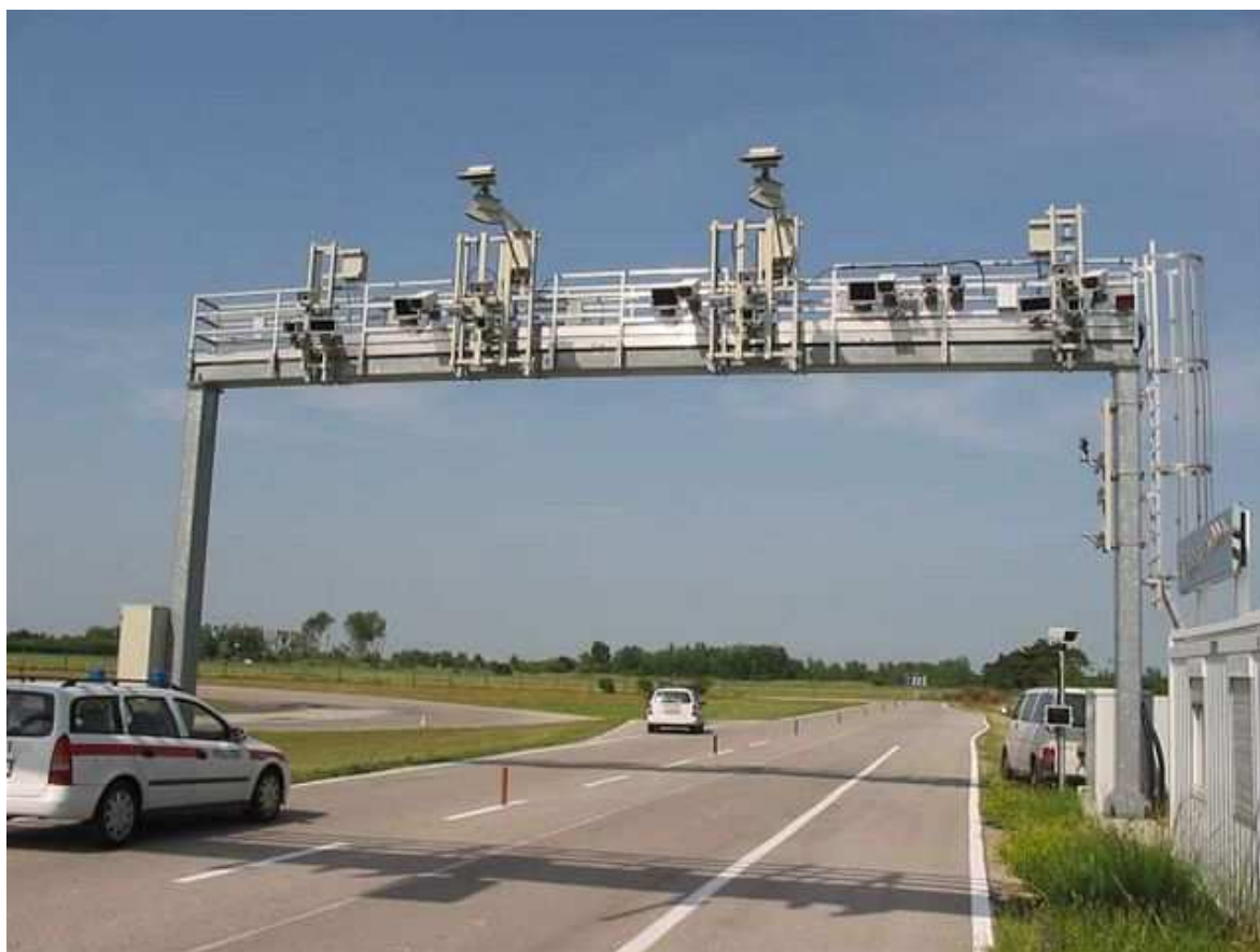
Obr. 5 Mýtný portál systému MLFF
