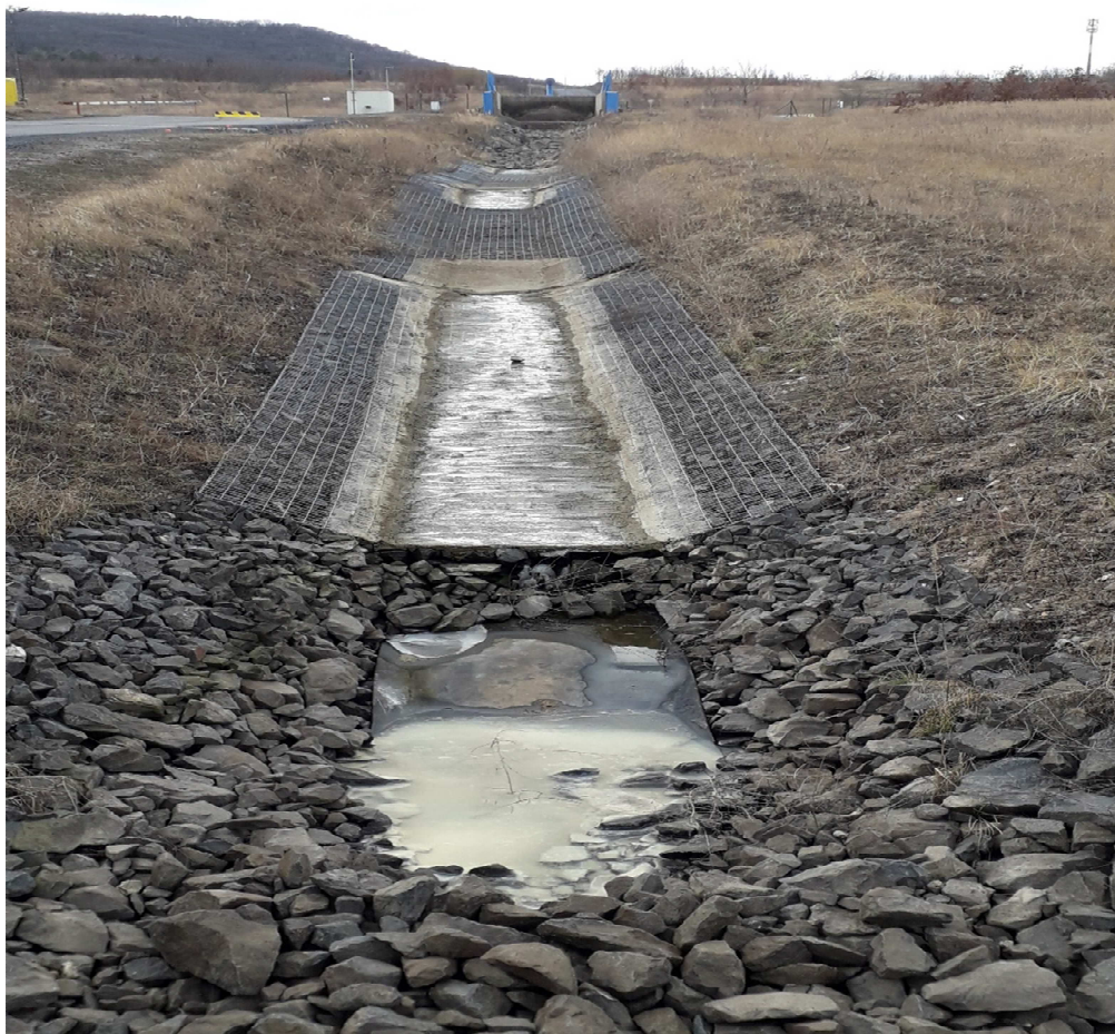
Obr. 19 Přivaděč vody dnes
