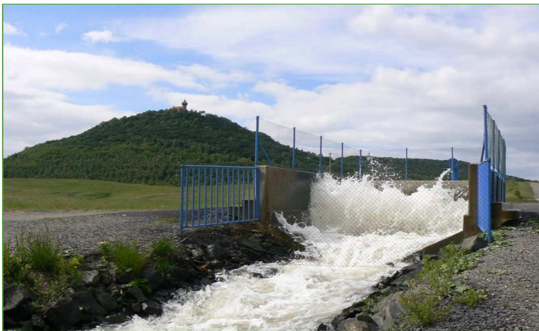
Obr. 18 Přivaděč vody v době napouštění jezera Most (PKÚ, 2008)
