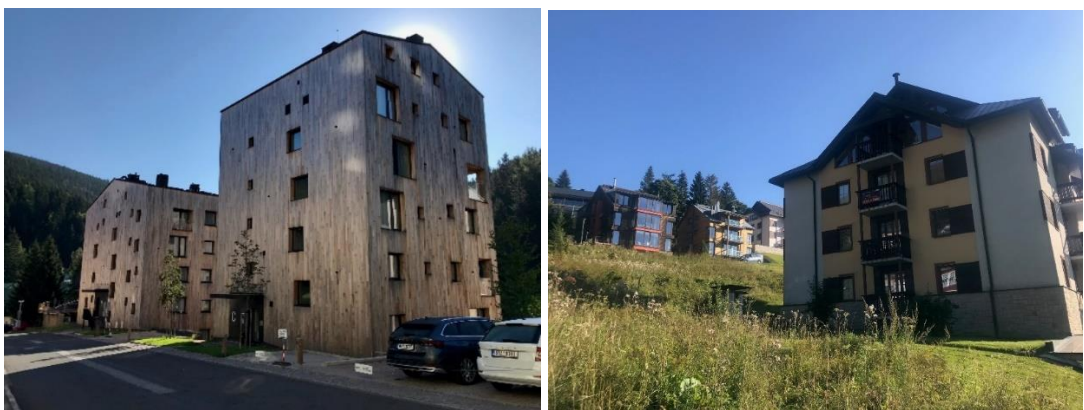
Obrázek 21: Aparthotel Svatý Vavřinec Pec p. Sněžkou, zástavba ve Špindlerově Mlýně
