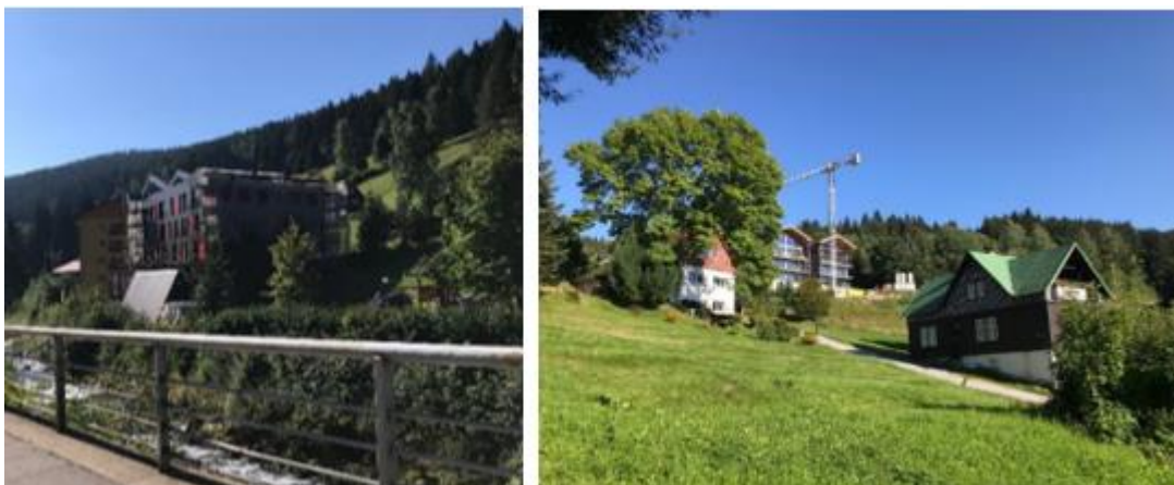
Obrázek 23: Vlčice Rezidence, Pec p. Sněžkou, probíhající výstavba ve Špindlerově Mlýně
