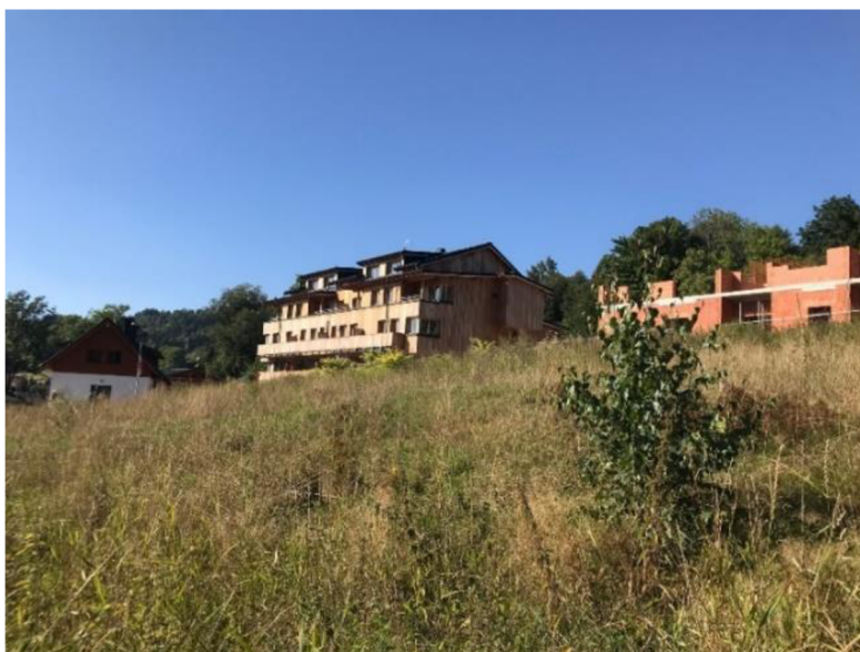
Obrázek 22: Stávající apartmánový dům v lokalitě Slunečná louka a další ve výstavbě, Černý Důl
