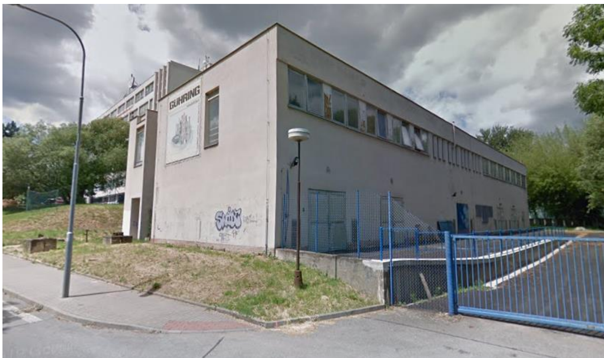
Obrázek 11-1 – pohled na budovu stávající rozvodny z ulice Hudcova
