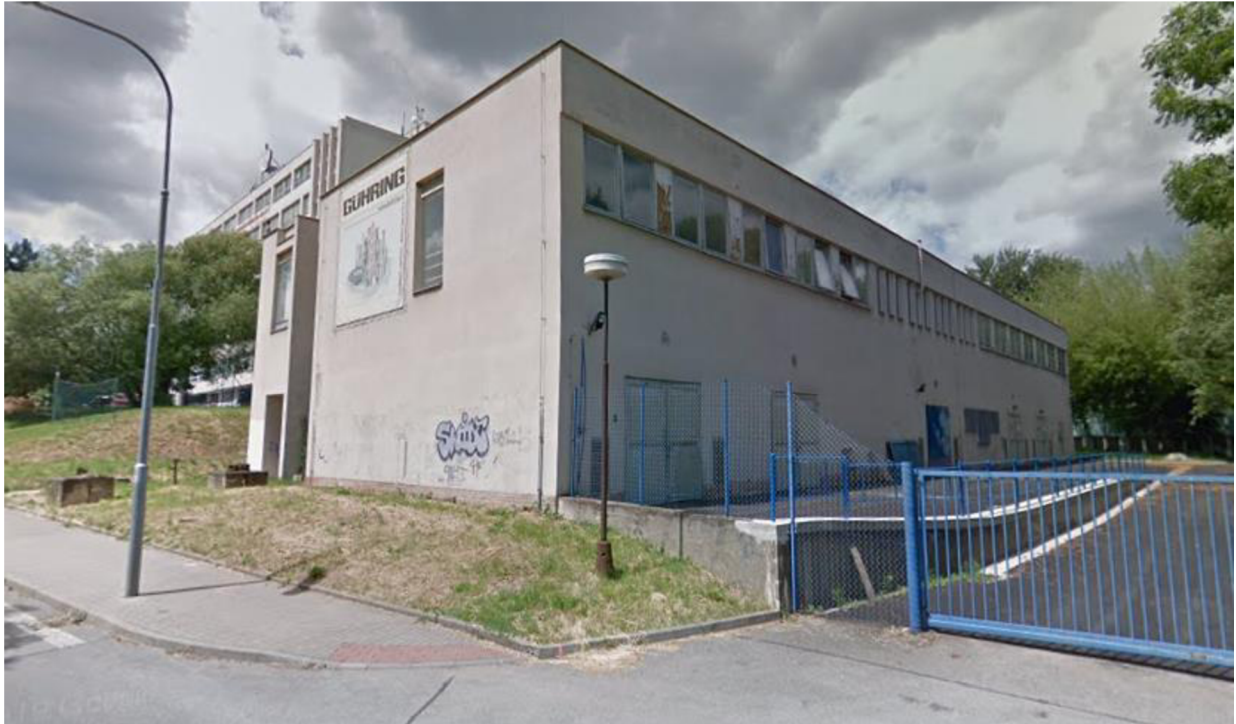
Obrázek 11-1 – pohled na budovu stávající rozvodny z ulice Hudcova
