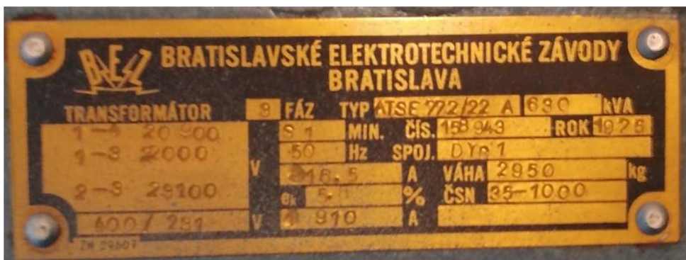
Obrázek 9-1 – fotografie štítku současně používaného transformátoru
