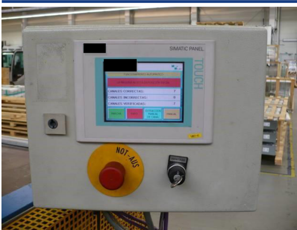
Obr. 40 Panel s vyhodnocenými zkouškami.
