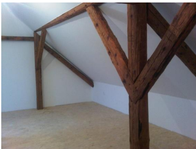
Obr. 17 Půdňí vestavba 1 (Quickhouse 2012)
