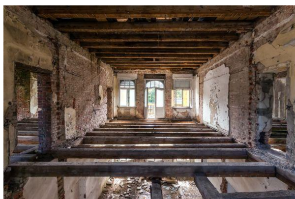
Obr. 2 Staré stropní a podlahové trámy (České stavby 2001-2013)
