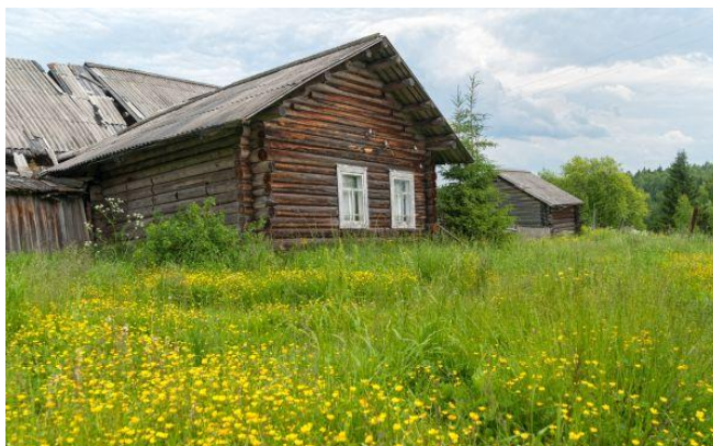
Obr. 1 Poškozená konstrukce roubenky (České stavby 2001-2013)
