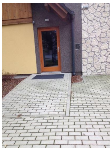
Obrázek 21 Vstup do objektu a nájezdovou rampou
