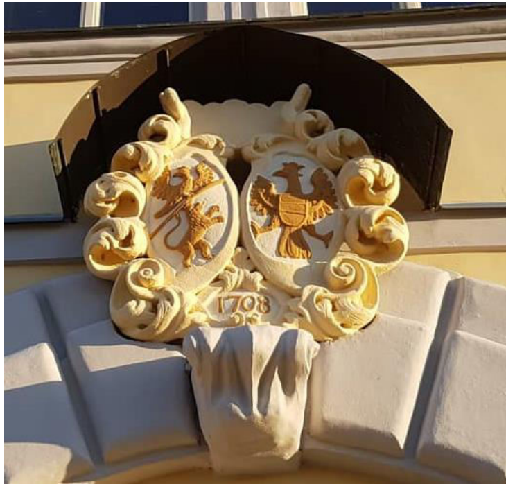
Obrázek 28 – Lubenec, bývalá porcelánka
