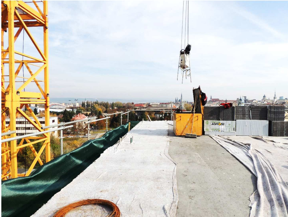
Obrázek 12 - ochrana betonové směsi fóliemi [1]
