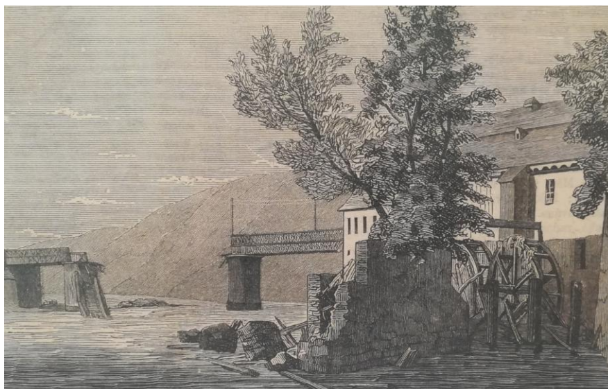
Obr. 9: Železniční most a mlýn u Dolních Mokropsů (Kozák 2007).
