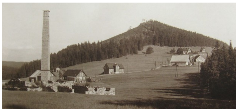
Obr. č. 5: Rozvaliny staré sklárny
