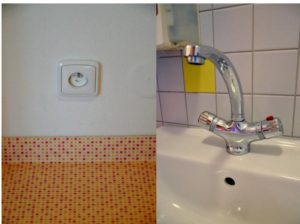
Obrázek 3. a 4. Kryty zásuvek, termostatická baterie
