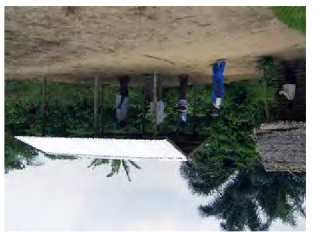
Proces výstavby je odlišný od toho, na který jsme zvyklí. V kongu se nejprve umístí sloupky, které podpoří střechu, poté je zhotovena střecha, pak dokončeny stěny a nakonec podlaha. Stěny jsou doplněny budovy, jsou volněné. Zářitko u nás jsme zvyklí začít základem nebo podlahou, stěny a podřpy a nakonec je dokončena střecha. [25]
