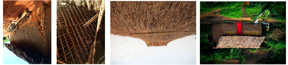
Proces výstavby je odlišný od toho, na který jsme zvyklí. V kongu se nejprve umístí sloupky, které podpoří střechu, poté je zhotovena střecha, pak dokončeny stěny a nakonec podlaha. Stěny jsou doplněny budovy, jsou volněné. Zářitko u nás jsme zvyklí začít základem nebo podlahou, stěny a podřpy a nakonec je dokončena střecha. [25]
