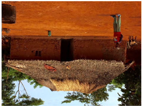
Proces výstavby je odlišný od toho, na který jsme zvyklí. V kongu se nejprve umístí sloupky, které podpoří střechu, poté je zhotovena střecha, pak dokončeny stěny a nakonec podlaha. Stěny jsou doplněny budovy, jsou volněné. Zářitko u nás jsme zvyklí začít základem nebo podlahou, stěny a podřpy a nakonec je dokončena střecha. [25]
