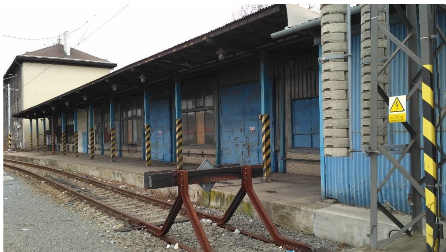
Obr. 46 Hala ČD Zdroj: vlastní fotografie
