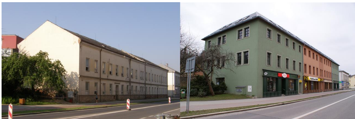
Obr. 18 Objekt okresní hygienické stanice před (vlevo) a po (vpravo) celkové regeneraci Zdroj: Stavební úpravy bývalé hygienické stanice města Přerova | PSS.cz, c2016
