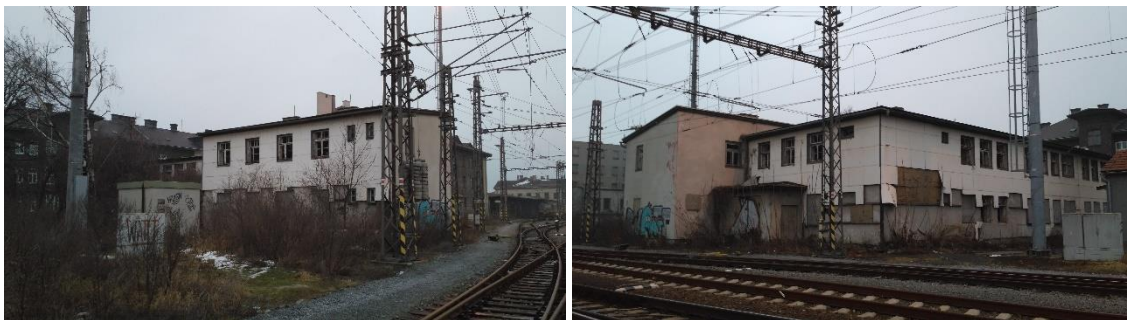
Obr. 28 Hospodářská správa ČD Zdroj: vlastní fotografie
