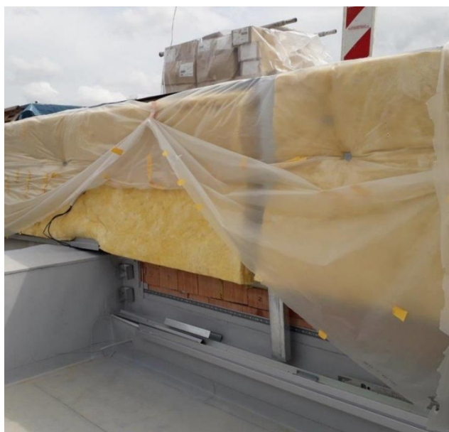
Obrázek 12 - Příklad měkké skelné vlny při použití jako tepelné izolace stěny atiky [autor]
