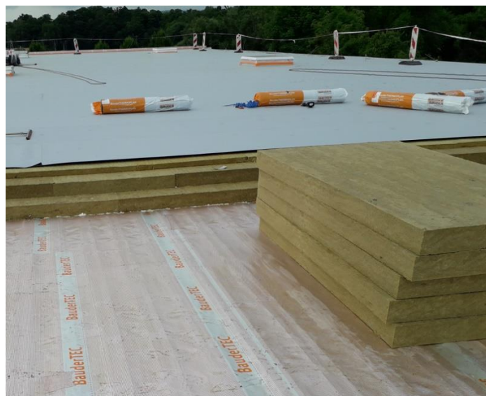
Obrázek 11 – Příklad tuhých desek z kamenné vlny tloušťky 140 mm při použití jako tepelná izolace ve skladbě střechy [autor]
