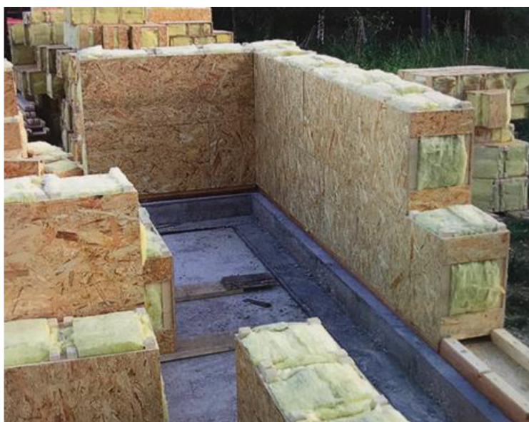
Obrázek 3 - Stěna z prefabrikovaných tvarovek pro pasivní dům [3, s. 38]
