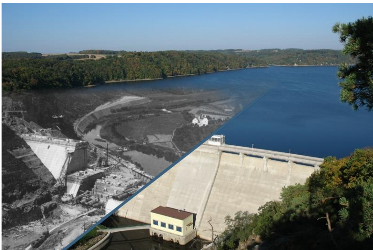
Obr. 5 Vranovská přehrada během výstavby a v provozu [25]
