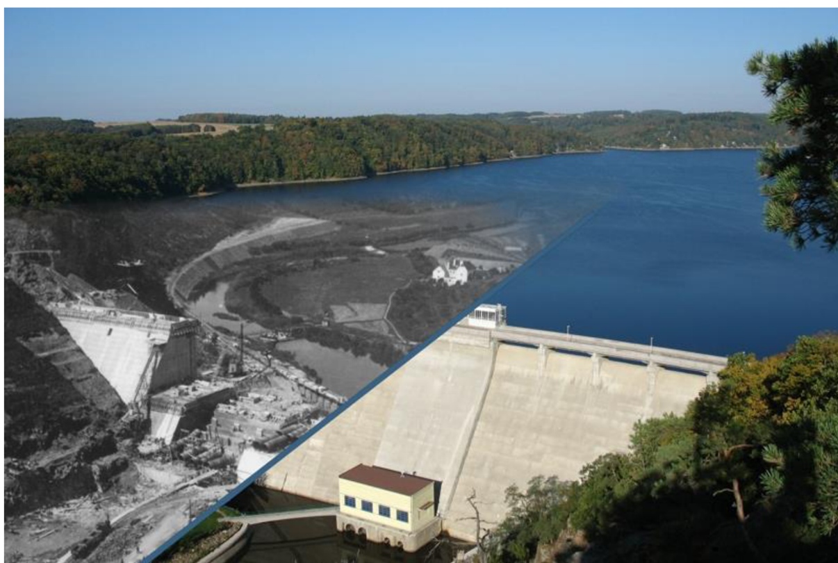
Obr. 5 Vranovská přehrada během výstavby a v provozu [25]
