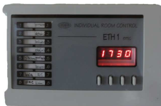
Obr. 19 Řídicí jednotka IRC regulace ETATHERM ETH 1 (vlastní zpracování)
