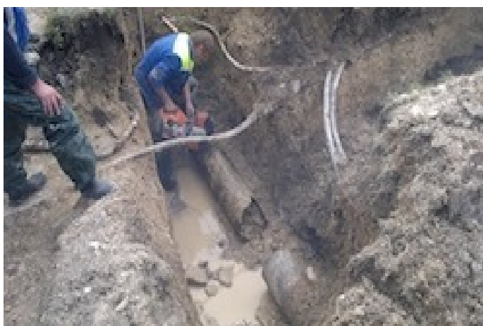
Příloha č. 4: Průběh opravy potrubí.
