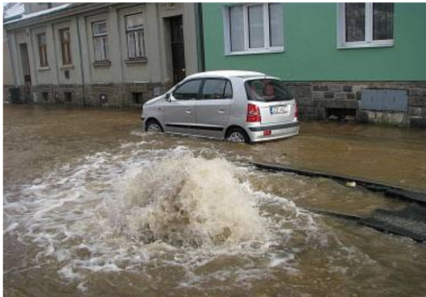
Příloha č. 1: Vývěr vody z prasklého řadu.
