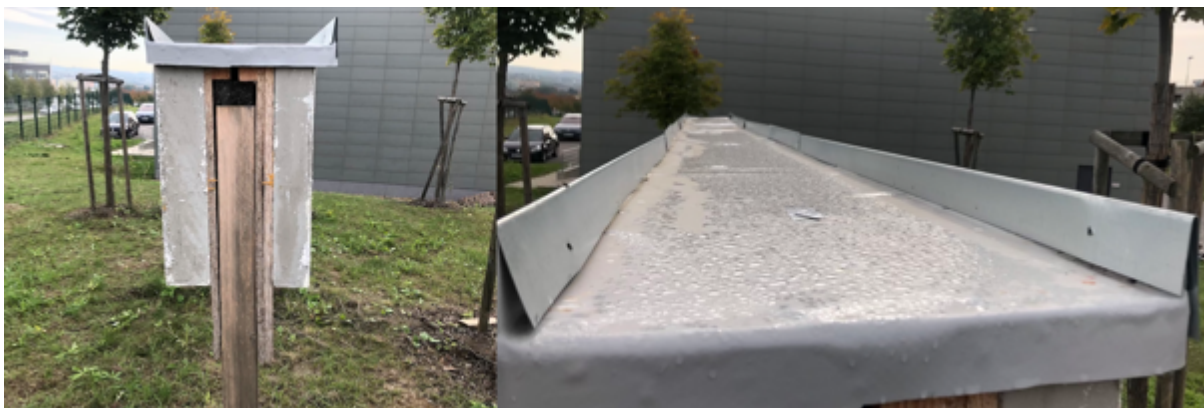
Obrázek 23 - Klempířské prvky na konstrukci v exteriéru
