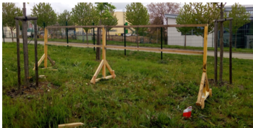
Obrázek 19 - Dřevěná nosná konstrukce
