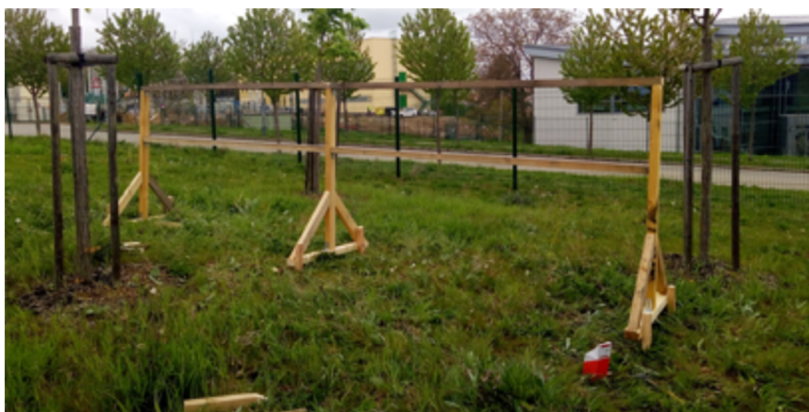
Obrázek 19 - Dřevěná nosná konstrukce
