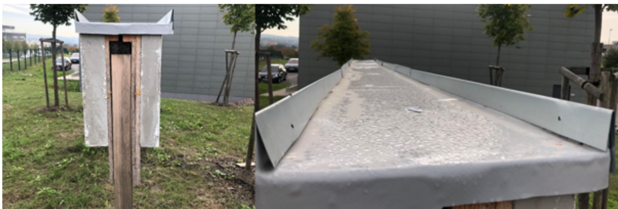
Obrázek 23 - Klempířské prvky na konstrukci v exteriéru
