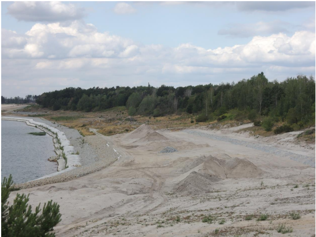
Obrázek 50: Sedlitz - příprava břehů hydriické rekultivace po ukončení těžby - vlastní foto (Lenc, 2019).
