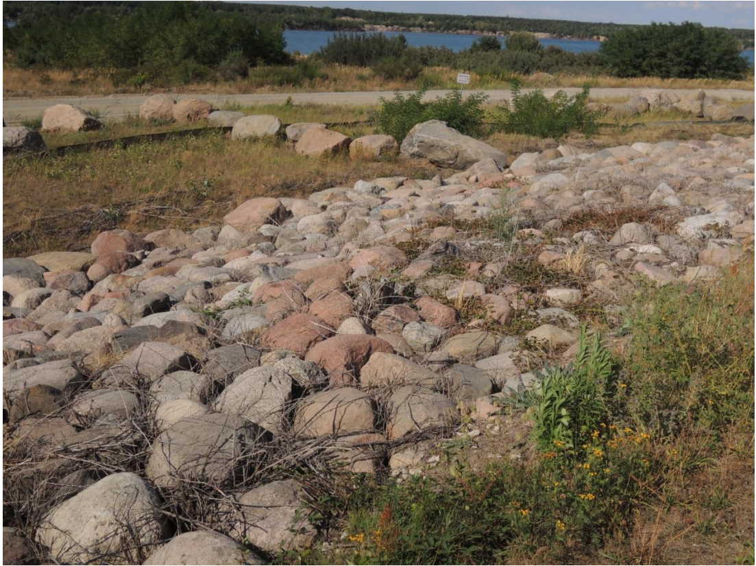
Obrázek 55: Greifenhain/Gräbendorf - příprava břehů hydričké rekultivace po ukončení těžby - vlastní foto (Lenc, 2019).
