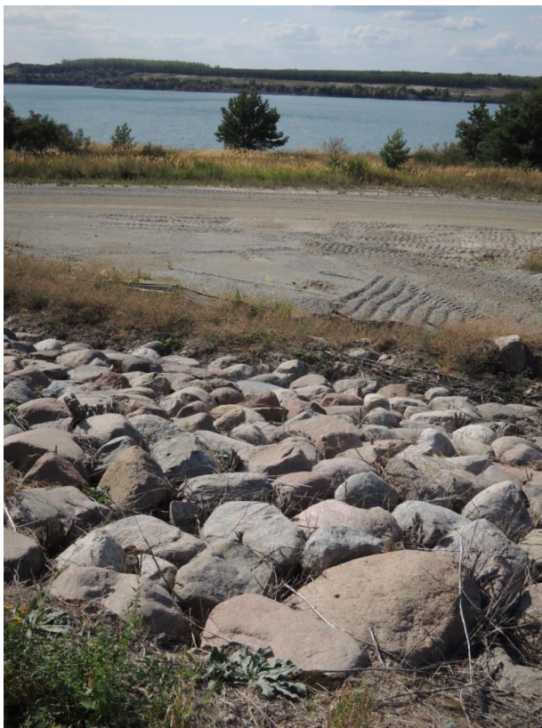
Obrázek 56: Greifenhain/Gräbendorf - příprava břehů hydričké rekultivace po ukončení těžby - vlastní foto (Lenc, 2019).
