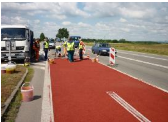
Obrázek 3 : Ukázka instalace bezpečnostního pásu Rocbinda; převzato z [14]
