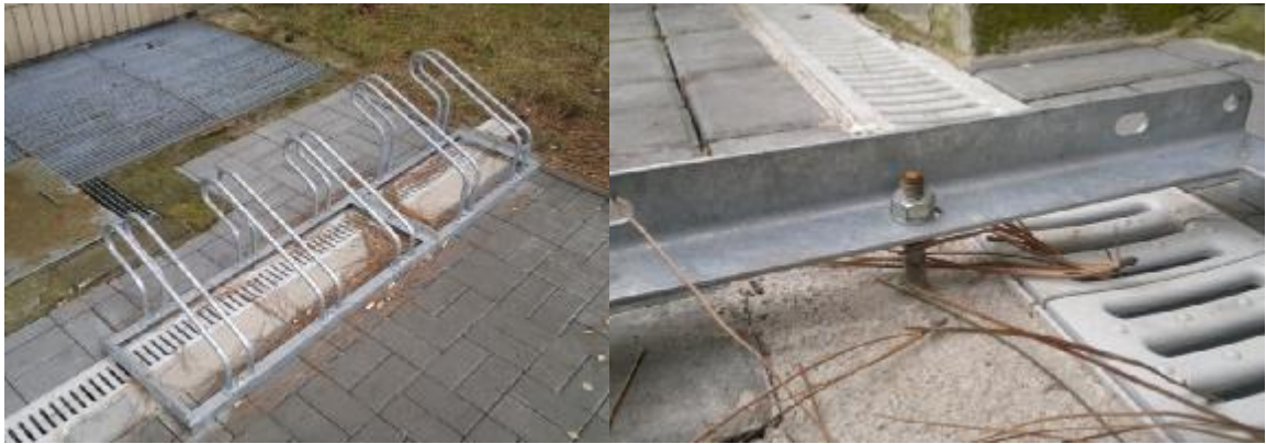
Obrázek 5 : Ukázka nevhodného uchycení cyklostojanu do podložky v areálu ČZU Praha [vlastní foto]
