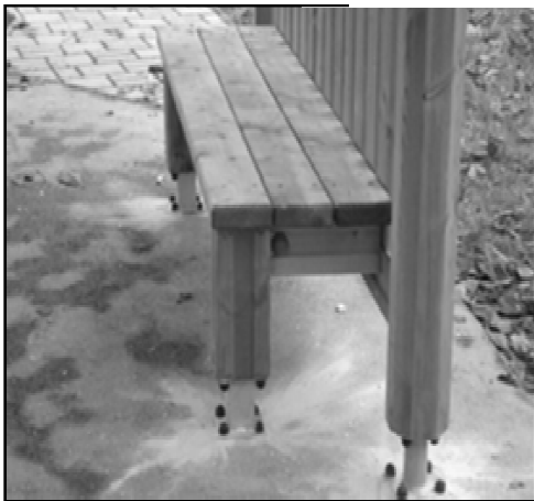
Foto č. 55 Realizace ukotvení
