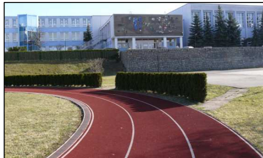
Foto č. 28 Čelní pohled na školu
