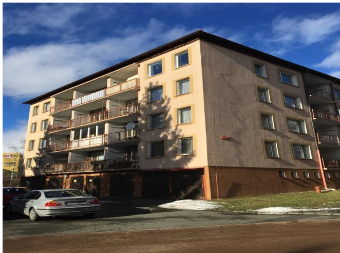
Obrázek č. 1 - budova
