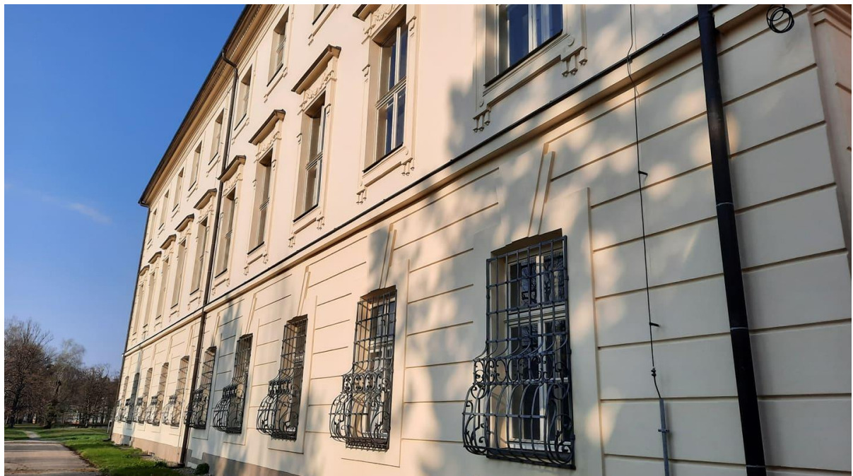
31. Západní průčelí při pohledu z parku, současný stav, Bystřice pod Hostýnem.
