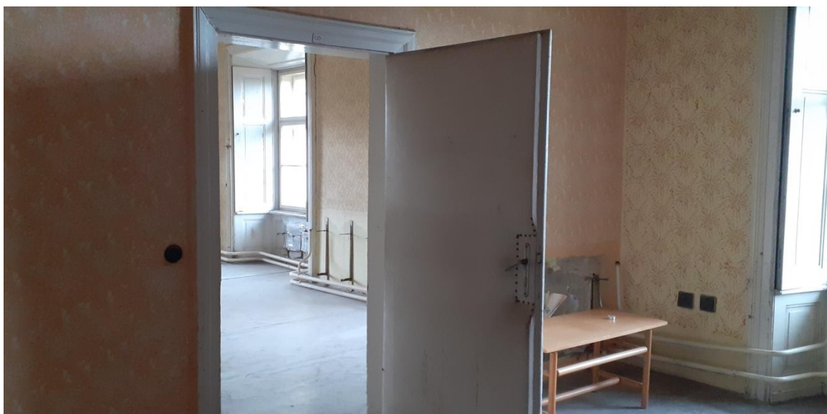
59. Průhled místnostmi v západním křídle, druhé patro, současný stav, Bystřice pod Hostýnem.
