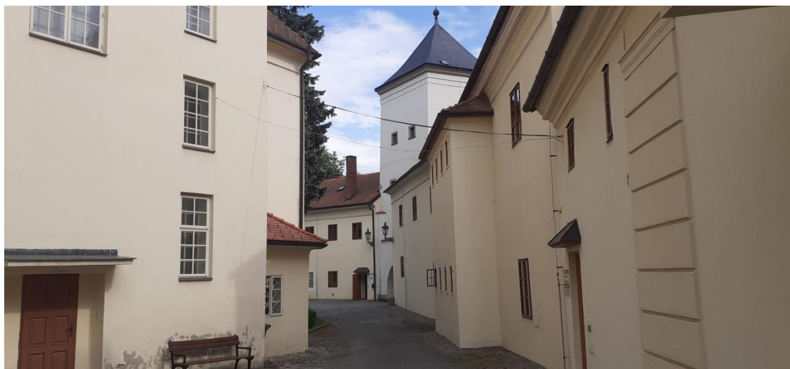
24. Budova západního křídla předzámčí a přístavku při pohledu z prvního nádvoří, současný stav, Bystřice pod Hostýnem.
