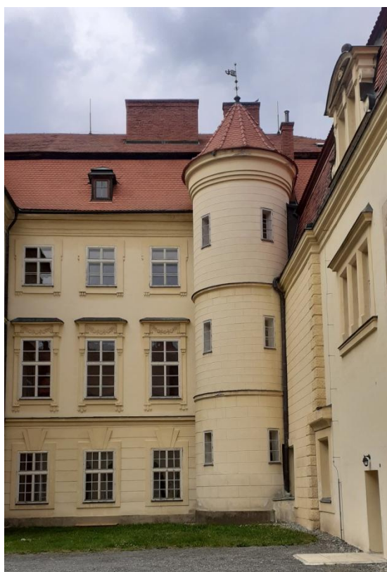
28. Severovýchodní část nádvoří s rondelem, současný stav, Bystřice pod Hostýnem.
