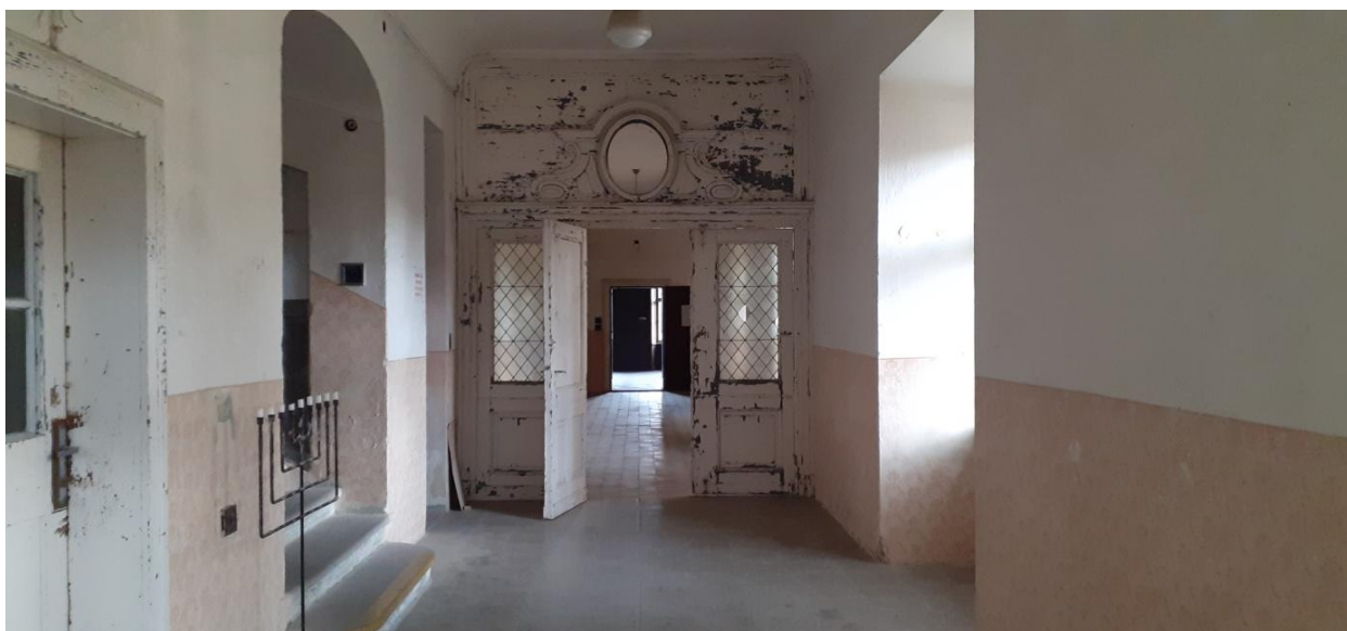
71. Dřevěná příčka s dveřmi u soukromých apartmánů, druhé patro, současný stav, Bystřice pod Hostýnem.
