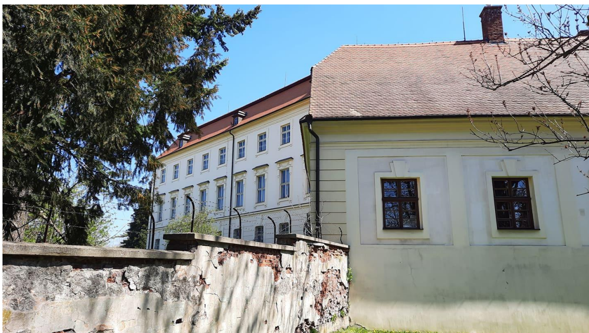
39. Zeď oddělující prostor bývalé soukromé zahrady od hradního příkopu, současný stav, Bystřice pod Hostýnem.
