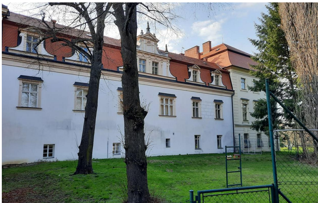
37. Východní průčelí při pohledu z parku, současný stav, Bystřice pod Hostýnem.
