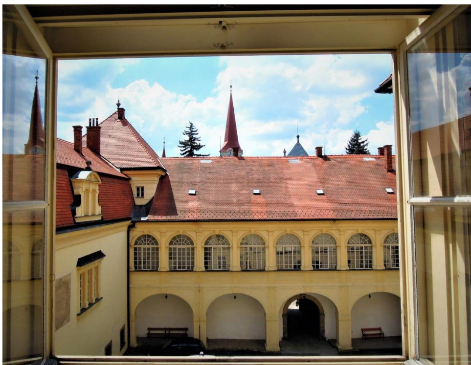
34. Jižní průčelí při pohledu ze severního křídla, současný stav, Bystřice pod Hostýnem.
