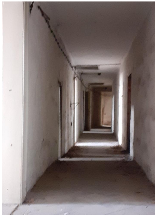
65. Chodba jižního křídla, druhé patro, současný stav, Bystřice pod Hostýnem.
