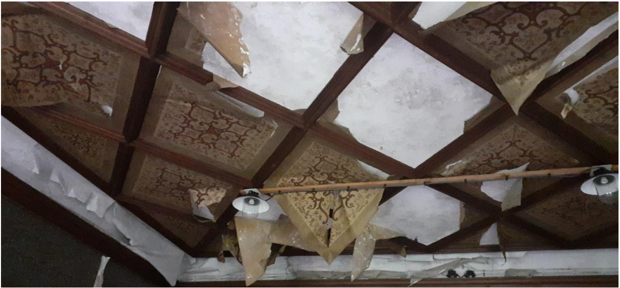
74. Papírové tapety v severním křídle, druhé patro, současný stav, Bystřice pod Hostýnem.
