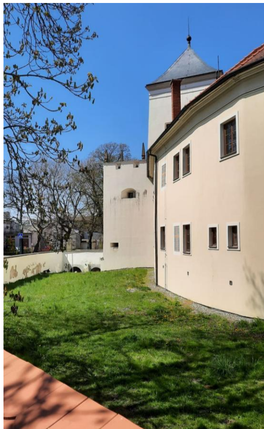
21. Hradní příkop, současný stav, Bystřice pod Hostýnem.
