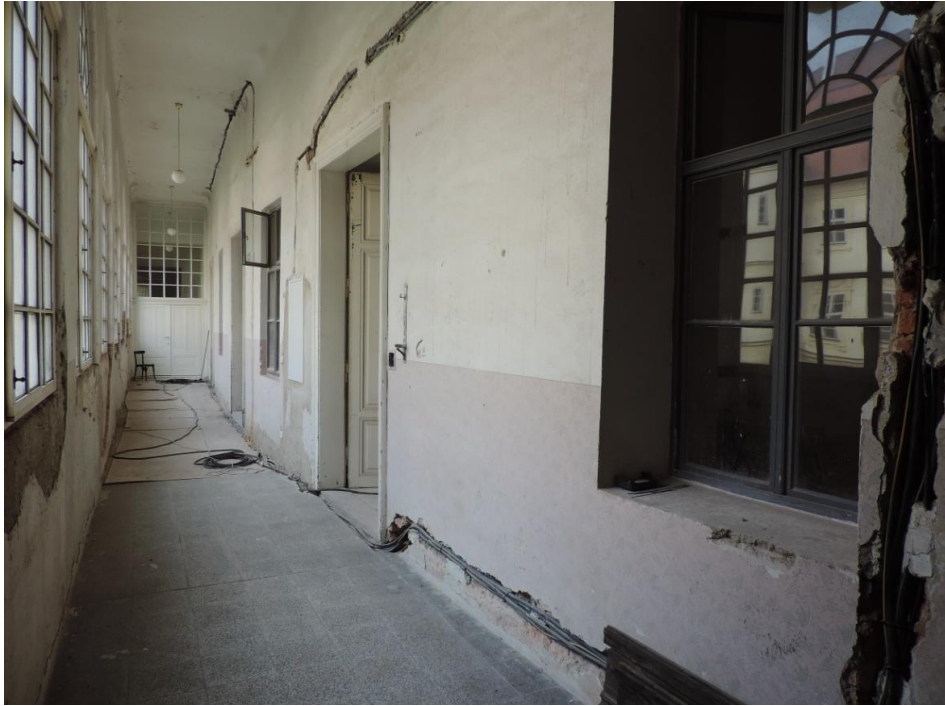
54. Chodba v jižním křídle, první patro, současný stav, Bystřice pod Hostýnem.
