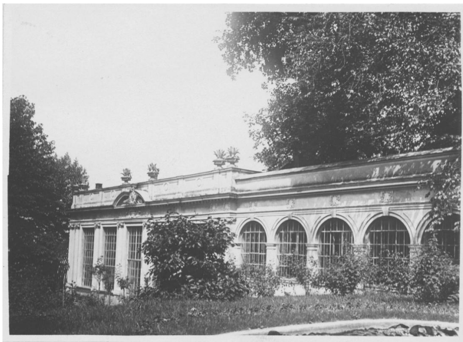
84. Bohumil Vavroušek, zimní zahrada a spojovací chodba při pohledu od zámku, 1916, Bystřice pod Hostýnem.
