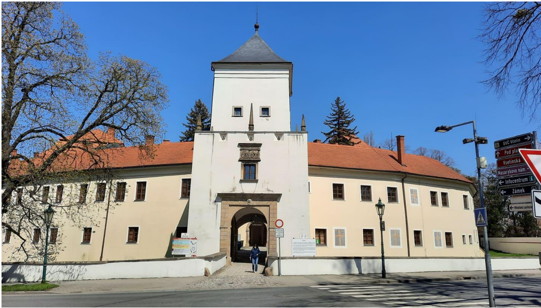
20. Hlavní průčelí věžové brány, současný stav, Bystřice pod Hostýnem.
