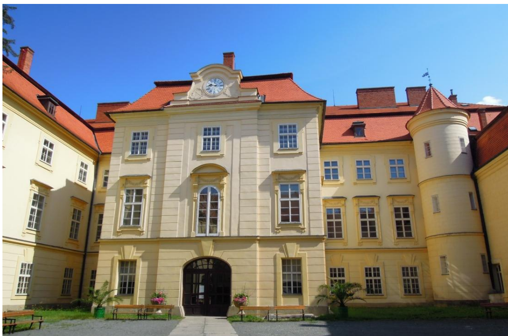
26. Hlavní severní průčelí při pohledu z druhého nádvoří, současný stav, Bystřice pod Hostýnem.
