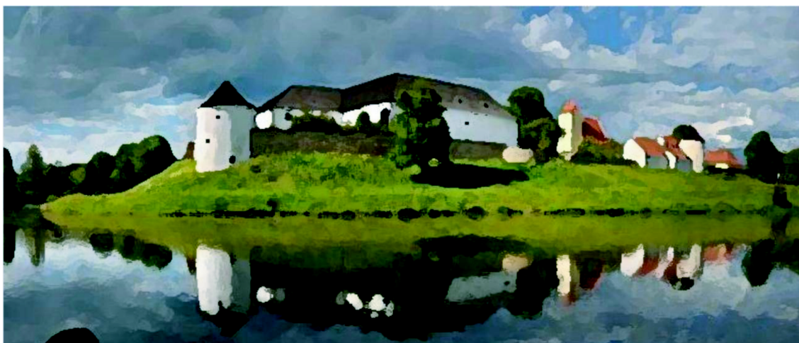
Obr. 3: opevnění tvrze Žumberk – válcové věže, zbytky hradby a rozsáhlý rybník
