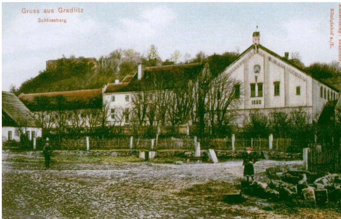
Obr. č. 6.: Kolorovaná fotografie z roku 1910 ukazuje pivovar a v pozadí zbytky hradních zdí. Budova pivovaru je bohužel aktuálně soukromým majitelem bouraná, po desítkách let, kdy ho nikdo neopravoval ani nevyužíval.
