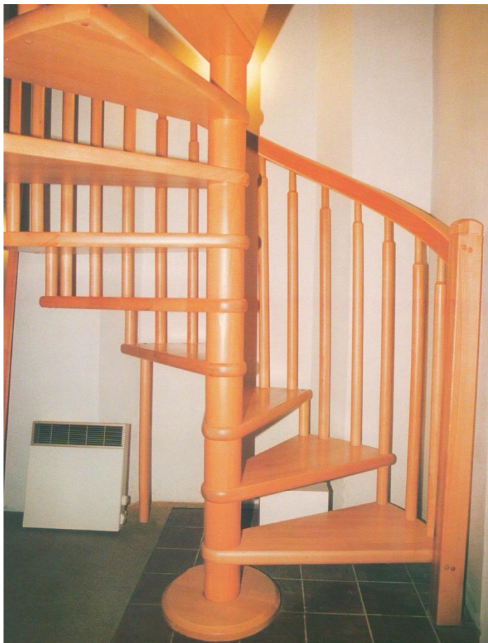
Obrázek 22: Křivočaré schodiště se schodišťovým vřetenem
