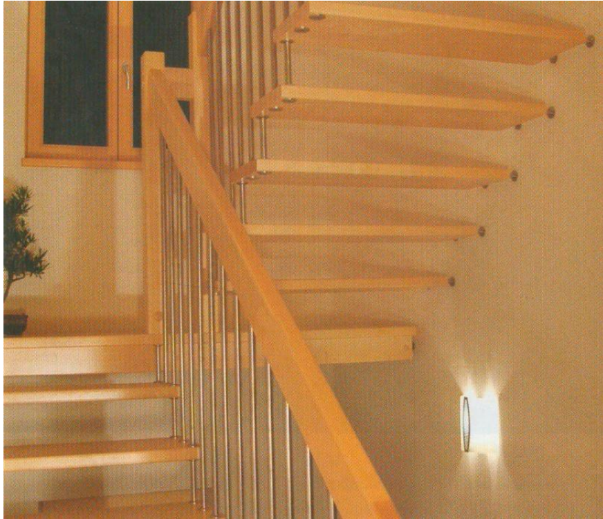
Obrázek 21: Schodiště zavěšené z jedné strany na madle a zdruhé vetknuté ve stěně
