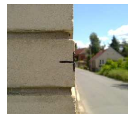
Obr.8: Stabilizace na zdech
