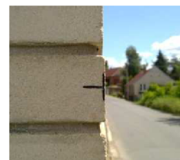
Obr.8: Stabilizace na zdech
